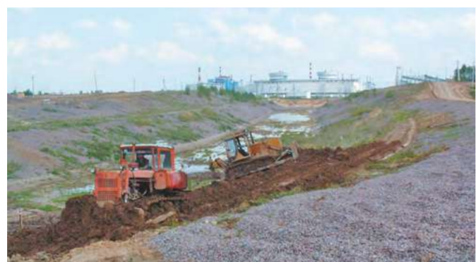
Строительство открытого отводящего земляного канала – расширение комплекса гидротехнических сооружений
