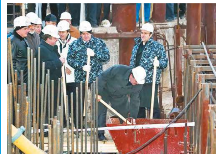
Возобновление строительства энергоблока № 4
