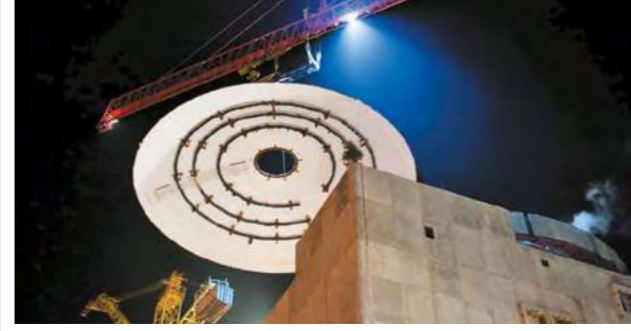
Подъем и установка купольной части защитной оболочки реакторного отделения энергоблока № 4
