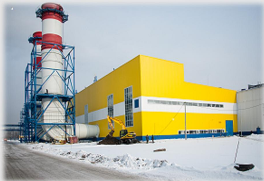
Новокузнецкая ГТЭС 298 МВт.
