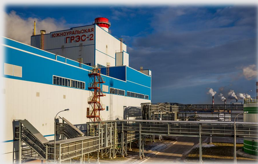
Южноуральская ГРЭС-2 420 МВт.
